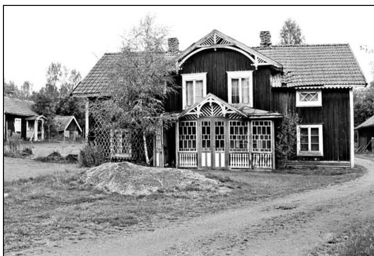
Manbyggnaden på Törnestorp 4:3
