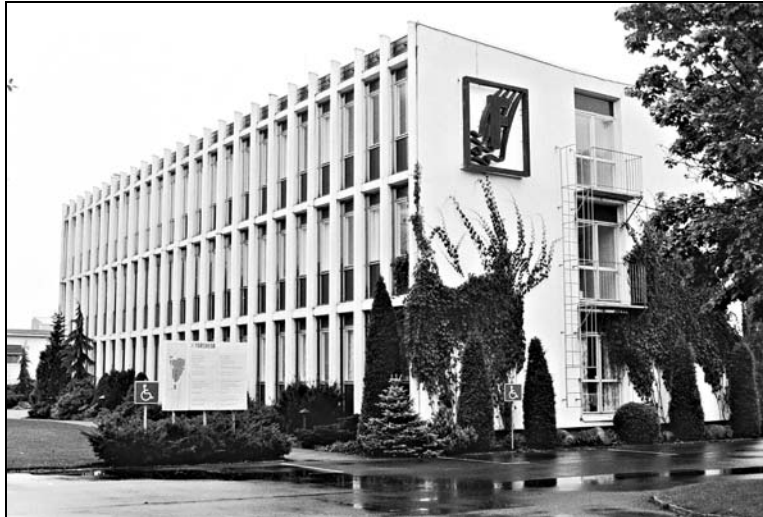
Forsheda AB: s kontorsbyggnad (Forsheda 5:79)
