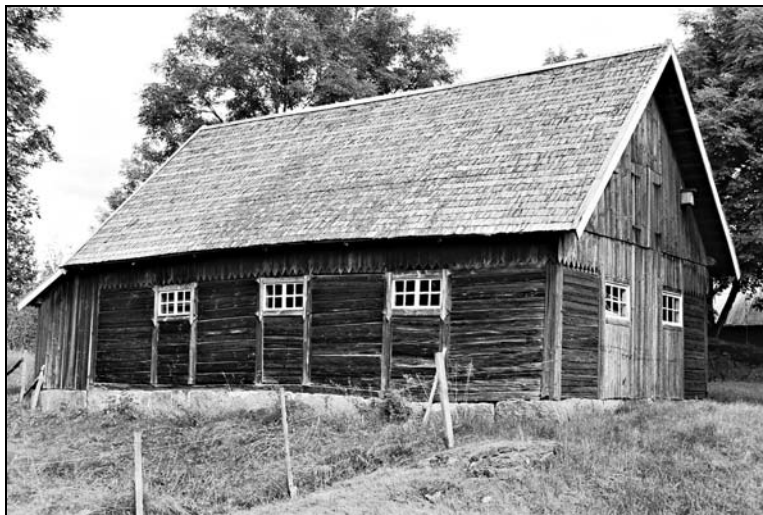
Knuttimrad bod med taktäckning av stickspån, Försebo 1:2
