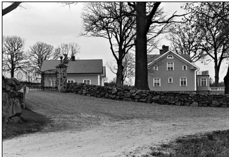
Hångers Byagård med flygelbyggnad, omgiven av stenmurar (Hånger 6:5)
