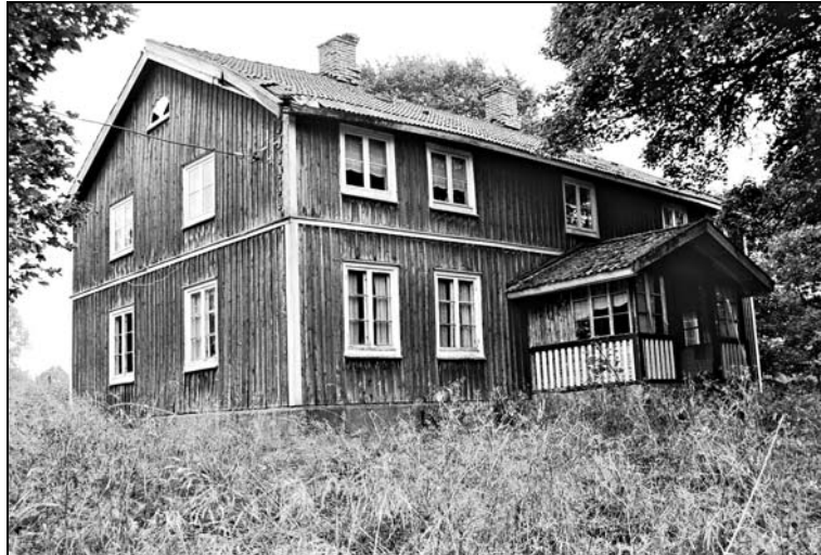
Övergiven manbyggnad på Östergården, Dannäs-Jonsbo 1:13
