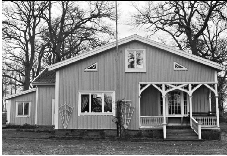
Manbyggnadens södra fasad på Helmershus 5:1
