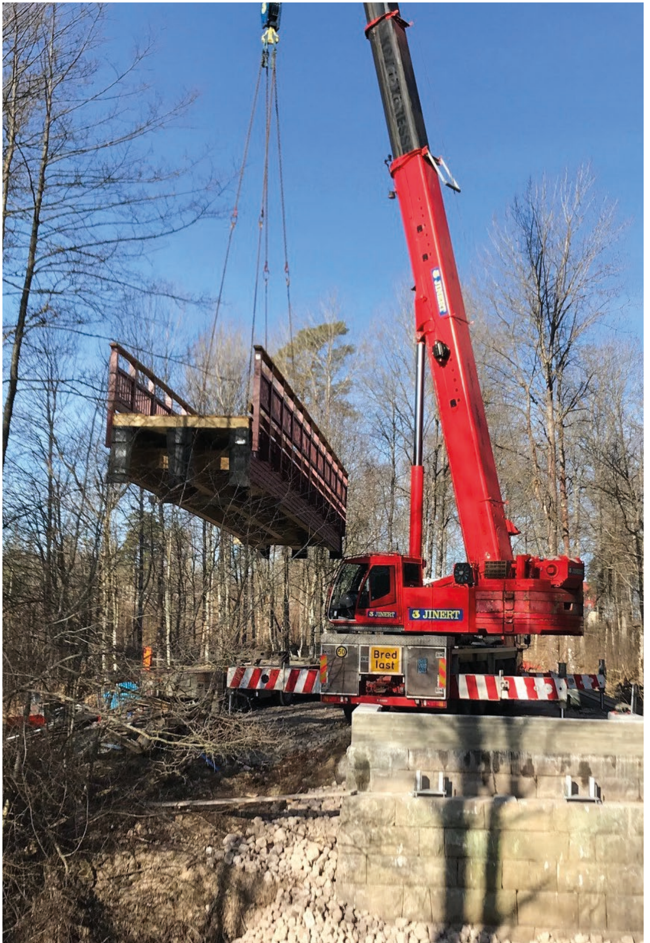
I slutet av mars lyftes den gamla järnbron över Storån i Forsheda bort. Ett par veckor senare lyftes den nya bron på plats. Bron är en del av det populära gångstråket Ångarundan.
