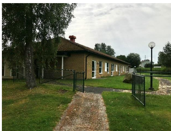
Befintlig byggnad inom planområdet
