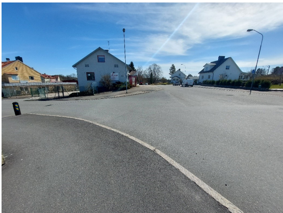
Foto från området med befintlig byggnad inom planområdet i mitten.
