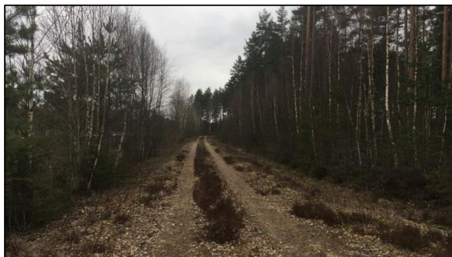
Det finns idag en mindre grusväg som löper parallellt med järnvägen. En ny väg kommer att byggas med längre avstånd från järnvägen.
