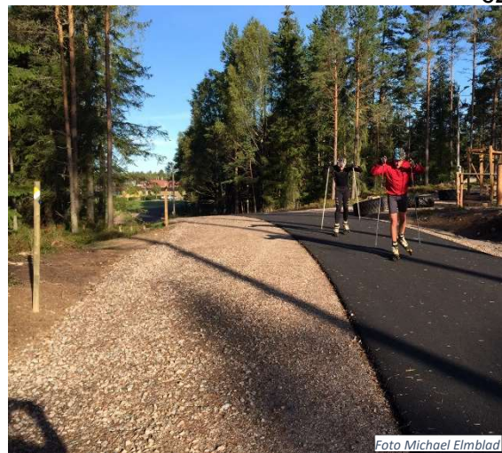
Asfaltering öppnar nya möjligheter.
