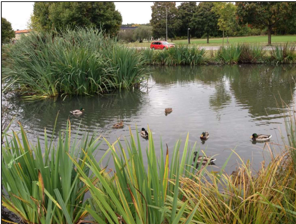
Figur 14. Exempel på dagvattendamm med permanent vattenspiegel. Bildkälla: Sweco.
