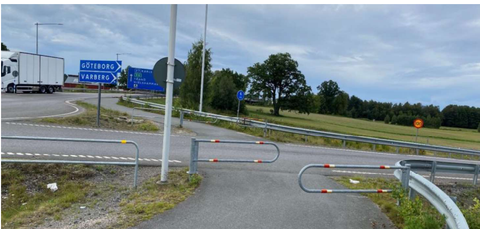
Figur 7. Foto (västerifrån) av gång- och cykelpassage över avfart i cirkulationsplats Nöbbele. Foto Sweco.
