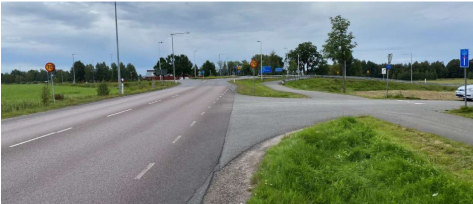
Figur 5. Foto (norrifrån) av korsning mellan Malmövägen och gata till koloniområde. Foto Sweco. Strax söder om planområdet finns cirkulationsplats Nöbbele (se foto i figur 6). Cirkulationsplatsen är enfältig med fyra anslutningar och ansluter till väg 27 via trafikplats Nöbbele. Påfarten till väg 27 (det västra benet i cirkulationsplatsen) har en gång- och cykelpassage som binder samman gång- och cykelbanan utmed Malmövägen (se foto i figur 7).
