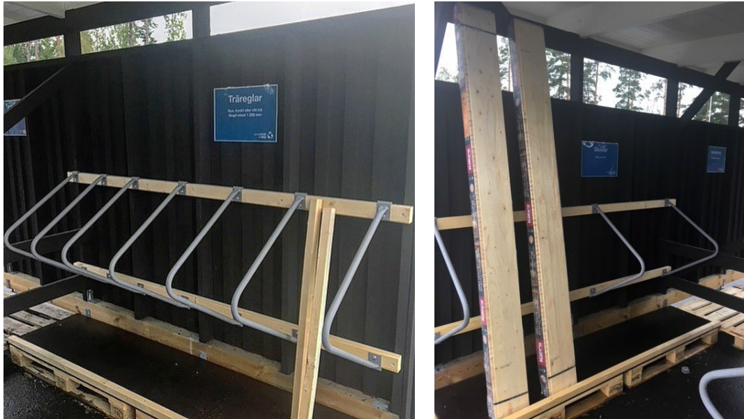
Bild 9. Byggboden i Jönköping. Källa: June&Avfall
