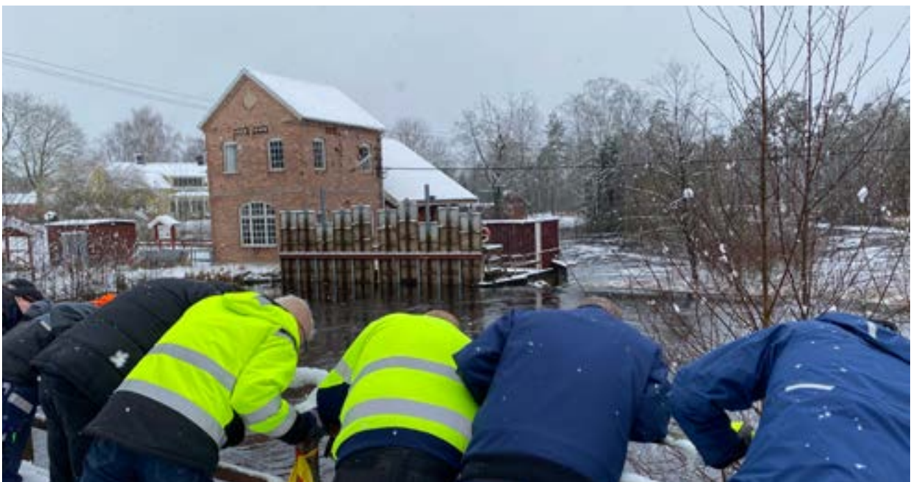
Inspektion av dammluckor vid Storån Forsheda i samband med översvämningen i februari 2020.
