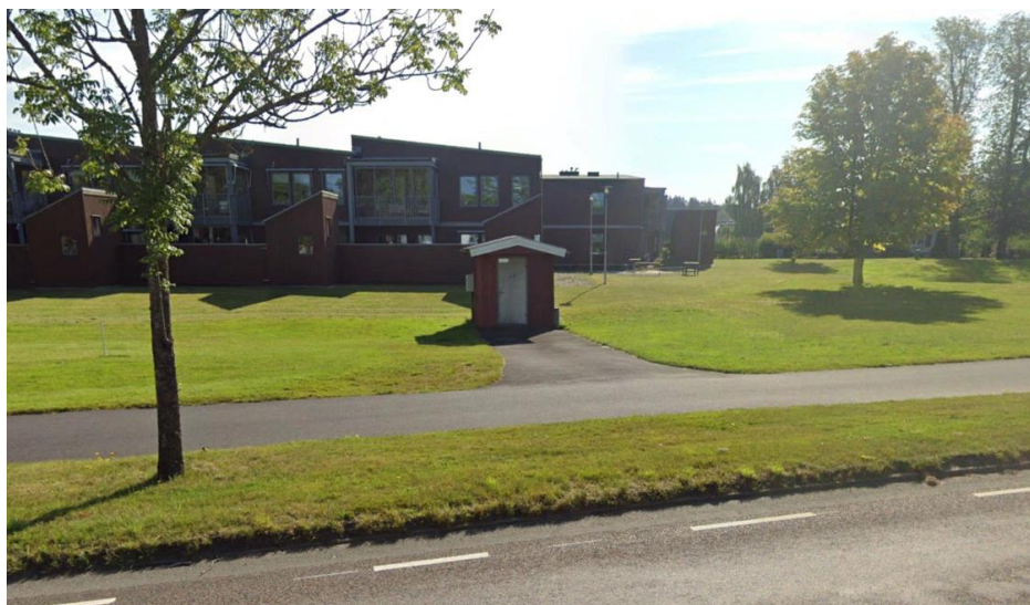
Figur 12. Den södra pumpstationen, här med perspektiv österut från Nydalavägen.
